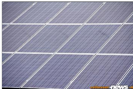
Diese Solarmodulen gehören zum neuen Bürgersolarpark, insgesamt wurden über 1.200 dieser Module installiert...
